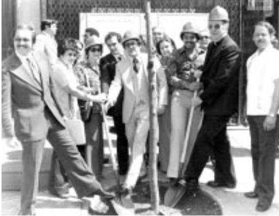
Ceremonia de inicio de las obras para las mejoras al Bloque de Oro, 1977. Documentos de la Spanish Merchants Association, colección Balch.
